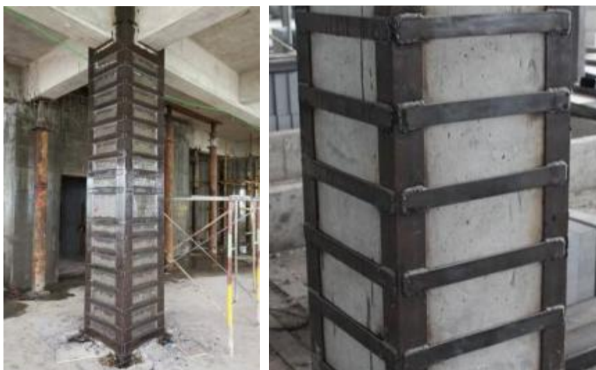
图2.3.1 混凝土柱外包型钢加固
