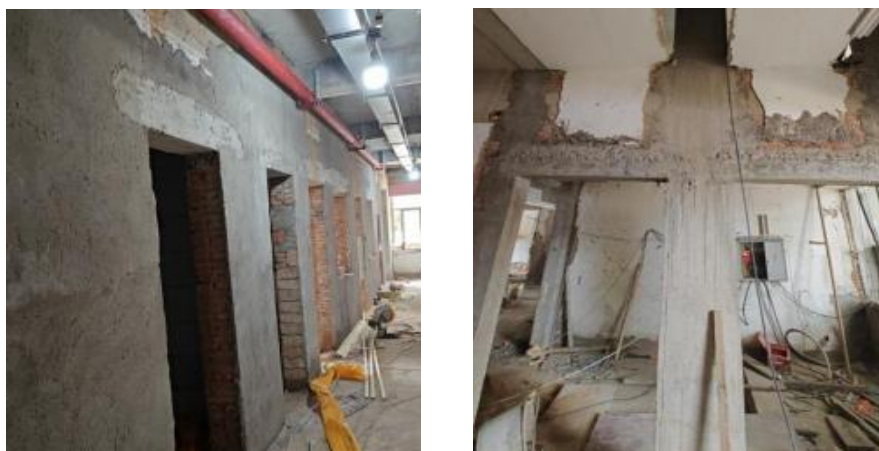
图1.2.1 洞口增设过梁、构造柱
