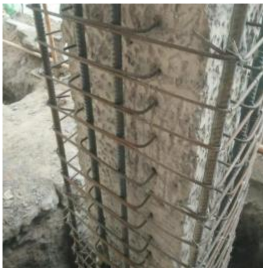
图2.2.1 混凝土柱加大截面
