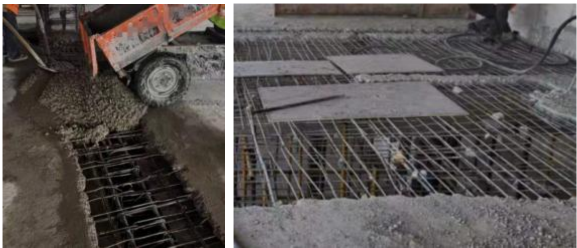
图2.4.2 混凝土梁、板置换法加固
