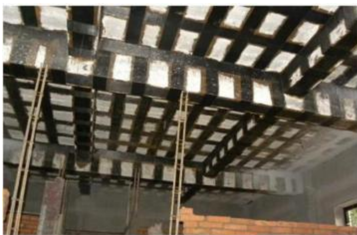
图1.4.1 楼板粘贴纤维布加固
