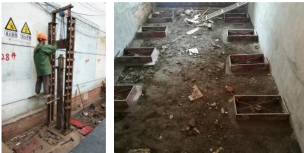
图1.1.1 增设锚杆静压钢管桩加固基础
