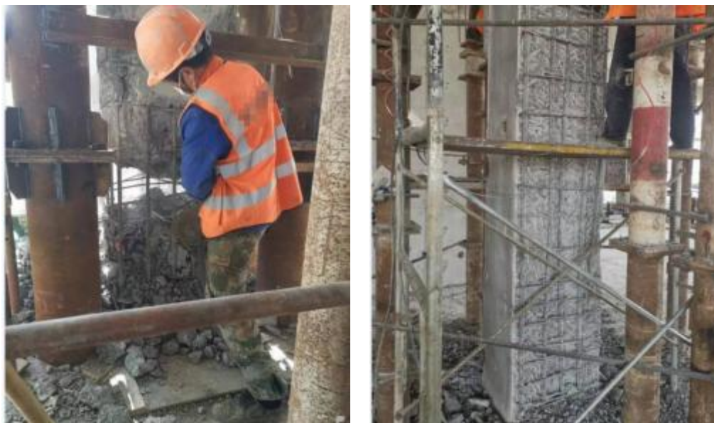
图2.1.2 混凝土柱整体置换
