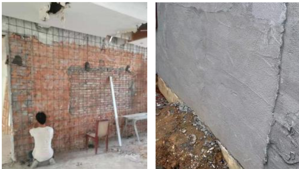
图1.3.1 钢筋网水泥砂浆面层加固
