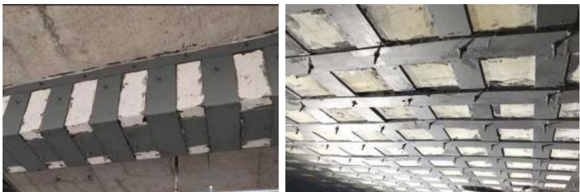
图2.5.1 混凝土梁、板粘贴钢板加固
